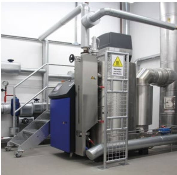
Abb.: Installation Einzeldampfanlage
